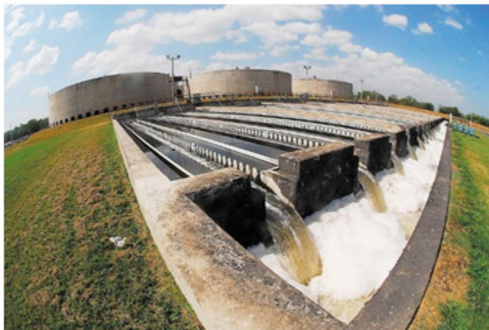
**Fig.26. Planta de tratamiento de aguas residuales ubicada a orillas del Lago Xolotlán. Esta planta tiene la capacidad de procesar hasta 180 mil m<sup>3</sup> por día. Fuente: <http://goo.gl/GOaugc>**
